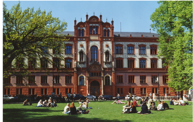
Abb.: Hauptgebäude der Universität Rostock
