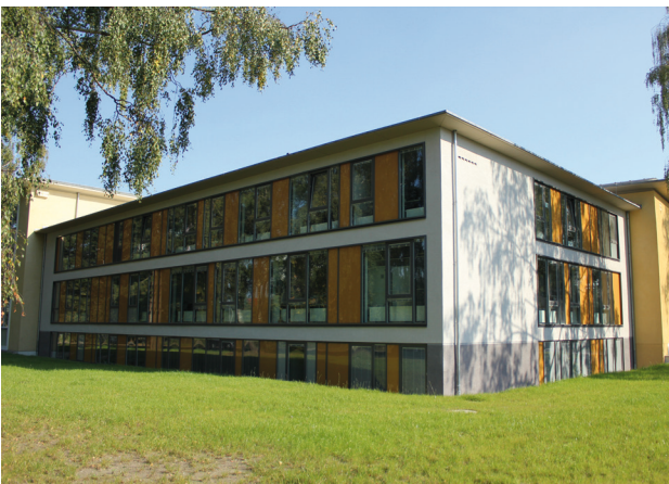
Abb.: Grundsaniertes Experimental-Gebäude (oben) und Verbindungsbau (unten)
