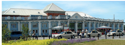
Rostock Hauptbahnhof – Nordgebäude
